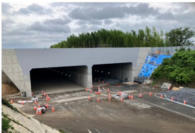
東関東自動車道・切り回し・地下道化 2026年8月 トンネル外観
