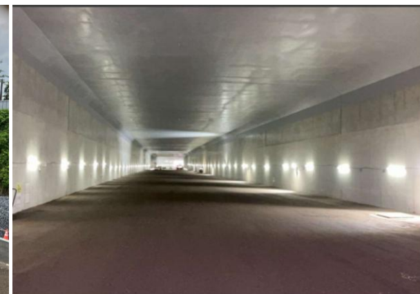
トンネル躯体内 路床工
