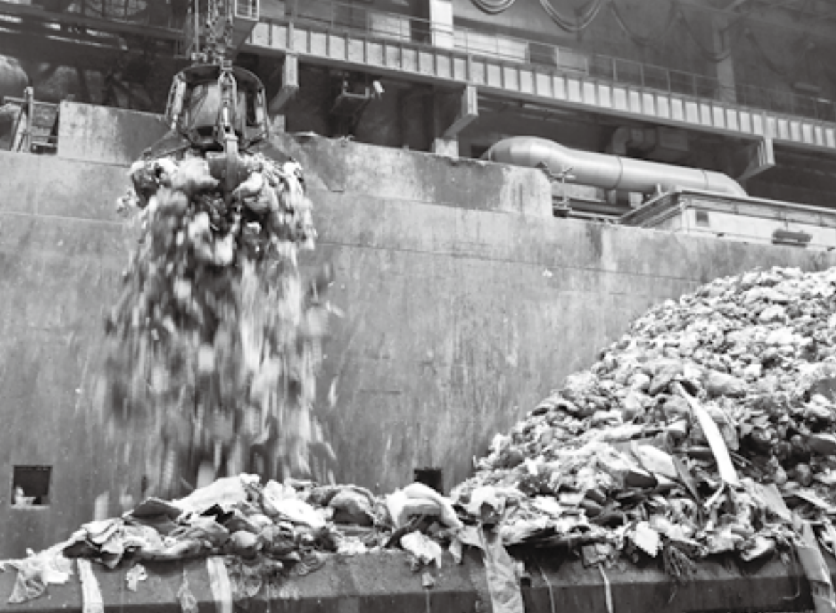
大量のごみが運び込まれる成田富里いずみ清掃工場
