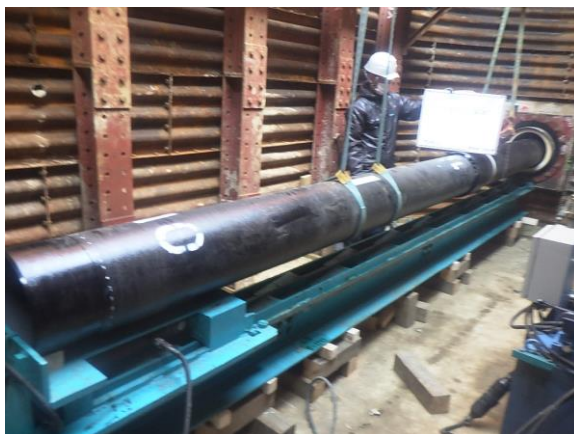
写真 6.3.1 管路耐震化工事
