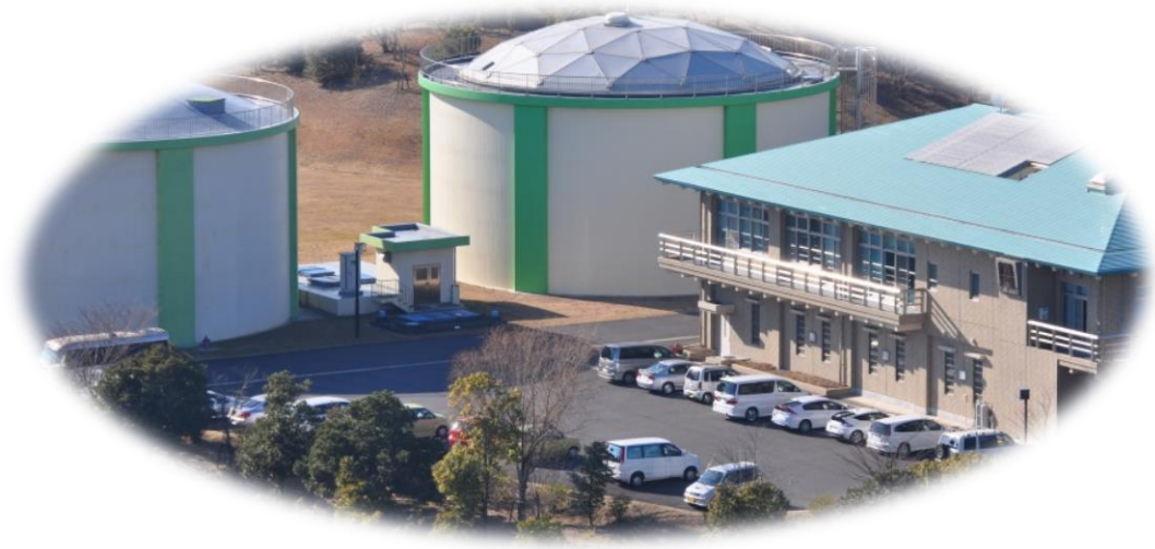
写真 3.1.2 水道部事業所（山口配水場内）
