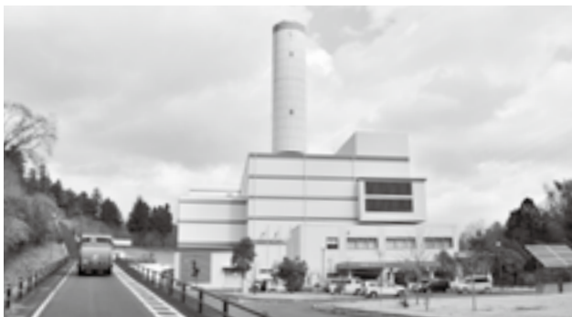
可燃ごみを処理する成田富里いずみ清掃工場
