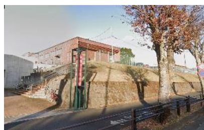
③中央公民館は西口大通りに面しているが、地盤が高く、階段を上がってアクセスする必要がある。
