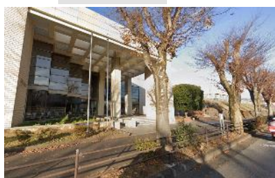
②図書館(本館)は西口大通りに面しており、視認性も高い。
