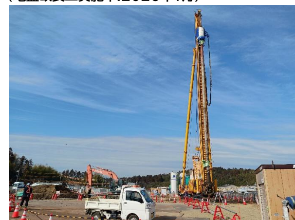
C滑走路南側造成工事(その1) (地盤改良工実施中:2026年1月)
