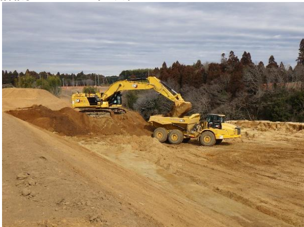
B滑走路延伸部造成整備 (掘削工:2026年1月)
