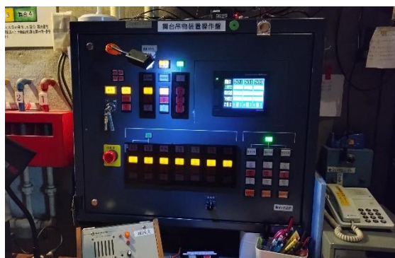
耐用年数が経過した舞台機構操作盤
