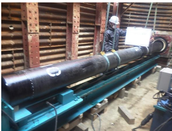
写真 6.3.1 管路耐震化工事
