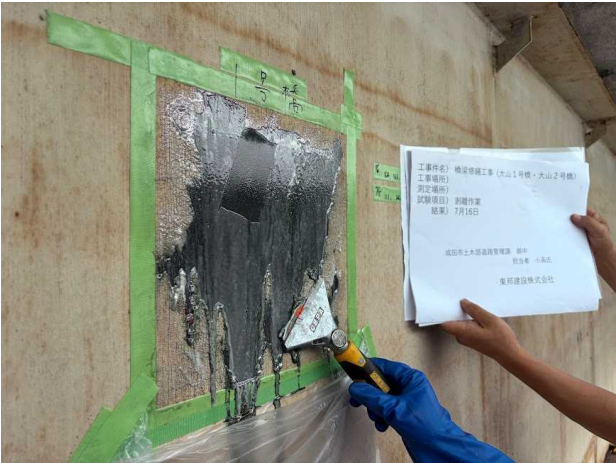
写真-3 剥離剤による試験施工状況
