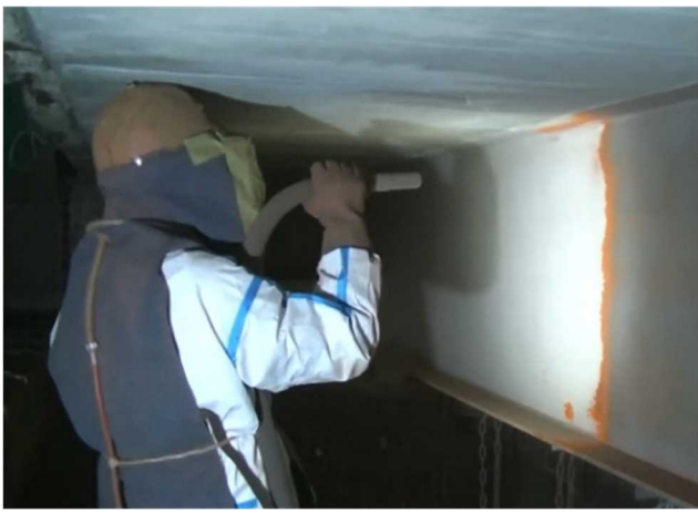
写真-4 ブラスト工法 施工例
