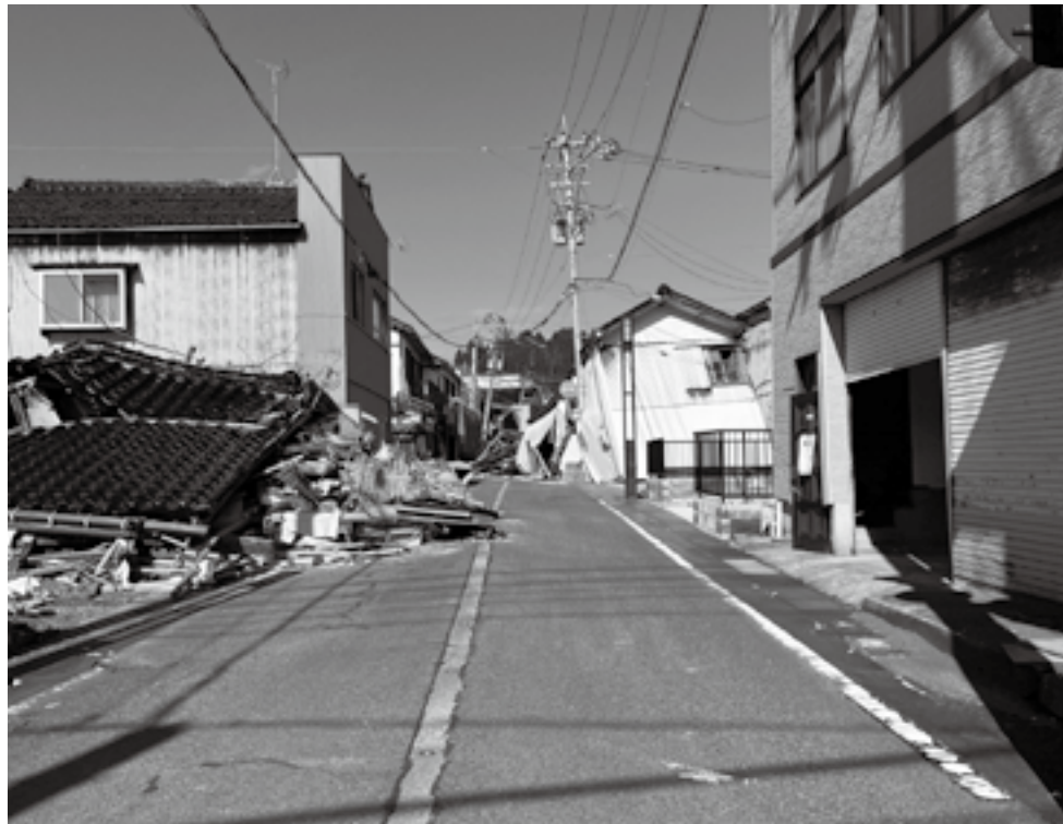
崩れた家屋が道路に及ぶ(令和6年能登半島地震)
