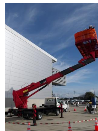
高所作業車体験
