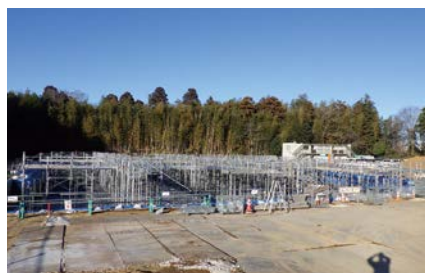
整備中の学校給食センター本所
