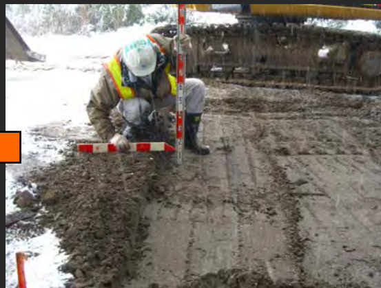
地盤改良面仕上げ
