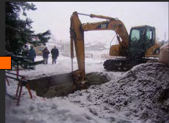
地盤改良：固化材攪拌
