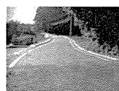
市道拡張工事の一部完成
