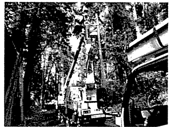
電力会社による復旧作業
