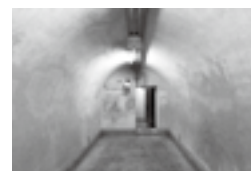
防空壕主室の様子
