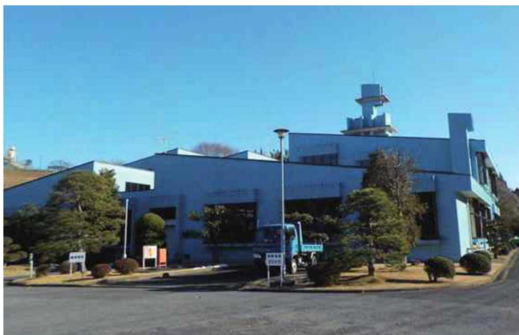
写真：成田浄化センター
