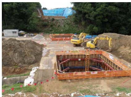
西三里塚大清水線の橋脚工事
