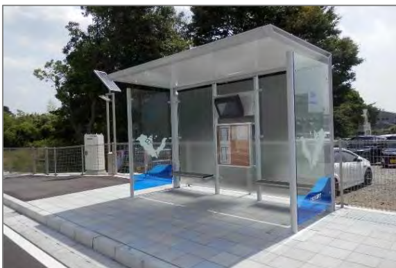
【バス停の上屋整備】（茨城県日立市）
