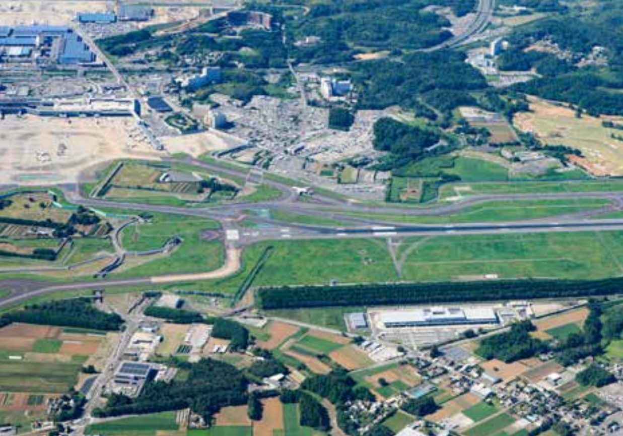
機能強化が進む成田空港と滑走路に隣接する新生成田市場
