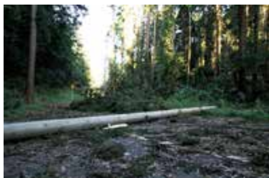
台風15号の影響で倒れた電柱
