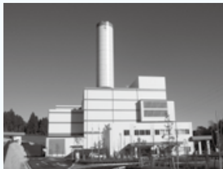
可燃ごみを処理する成田富里いずみ清掃工場
