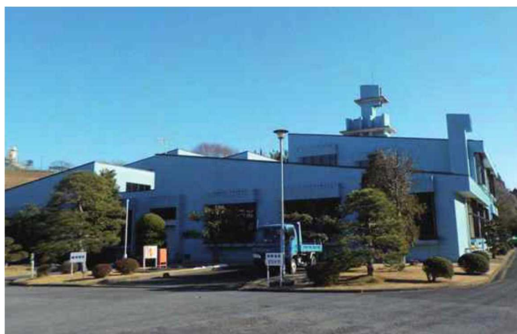
写真：成田浄化センター
