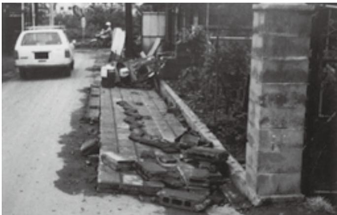
地震の揺れで倒壊したブロック塀
