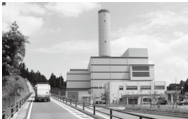
ごみ処理施設の安定稼働のために
