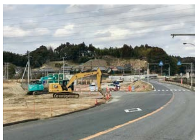
国道51号の寺台地先から東金山地先までの拡幅工事
