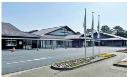
供用開始から20年が経過した保健福祉館
