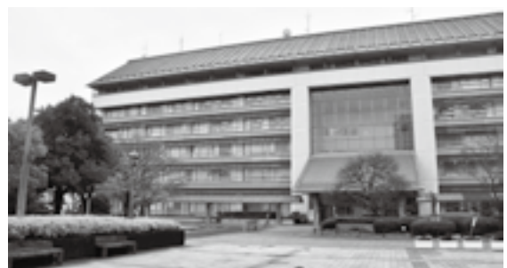
市役所の外観
