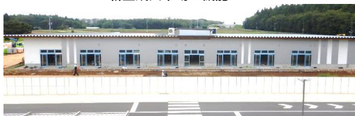
工事中の関連食品棟
