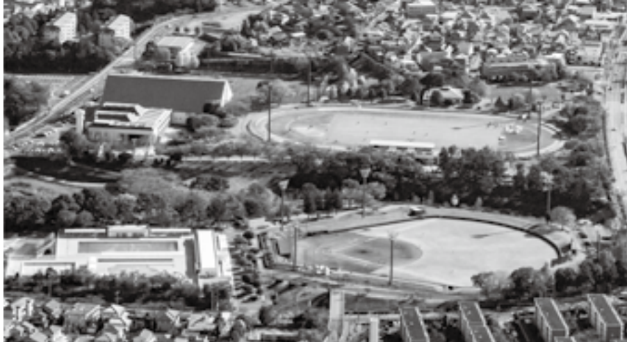
上空から見た「重兵衛スポーツフィールド中台」
