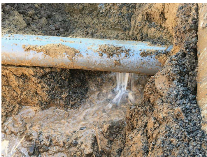
(例) 漏水状況
