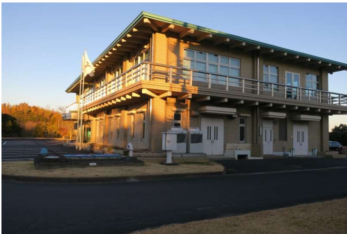
(例) 漏水箇所は建物裏側
