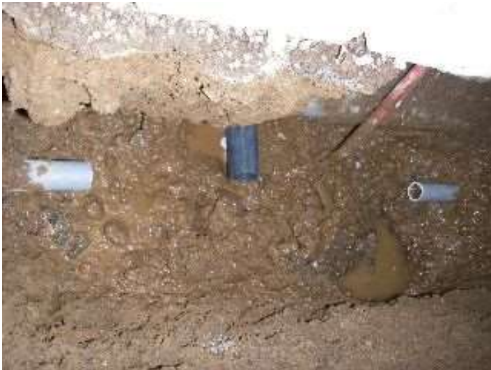
(例) 既設給水管撤去状況
