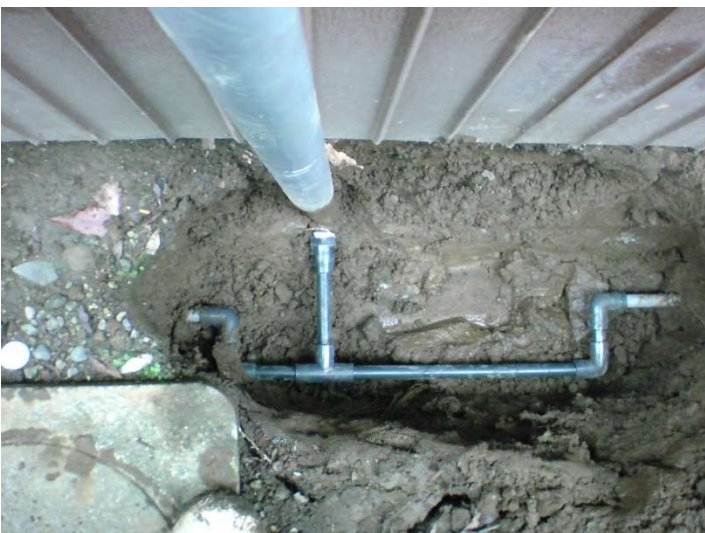
(例) 給水管修繕状況
