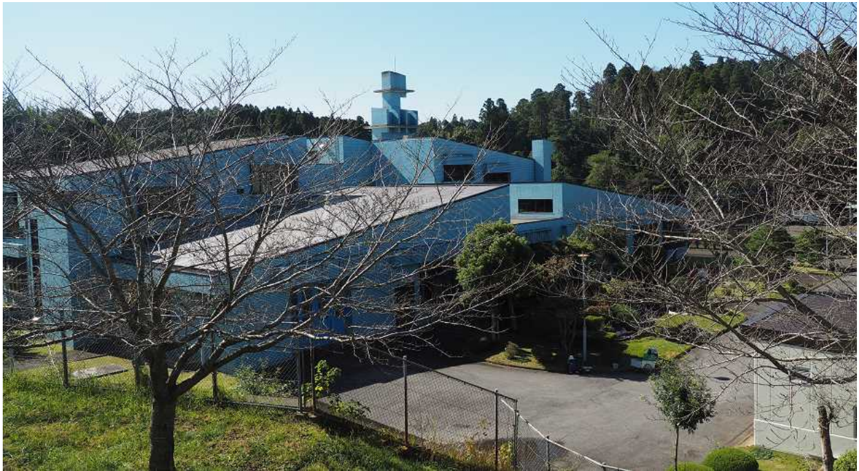
【図 24】 成田浄化センター
