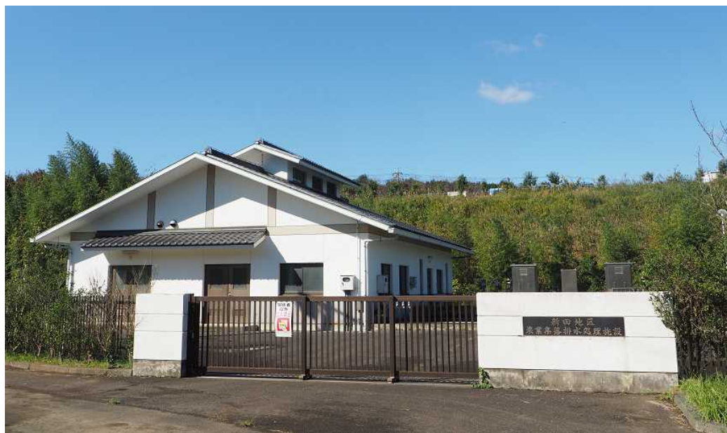
【図 21】農業集落排水処理施設（新田地区）
