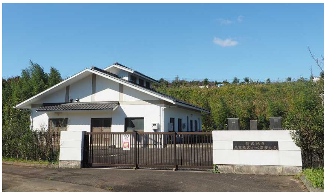
【図 21】農業集落排水処理施設（新田地区）
