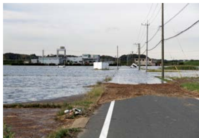
令和元年10月25日の大雨による道路冠水
