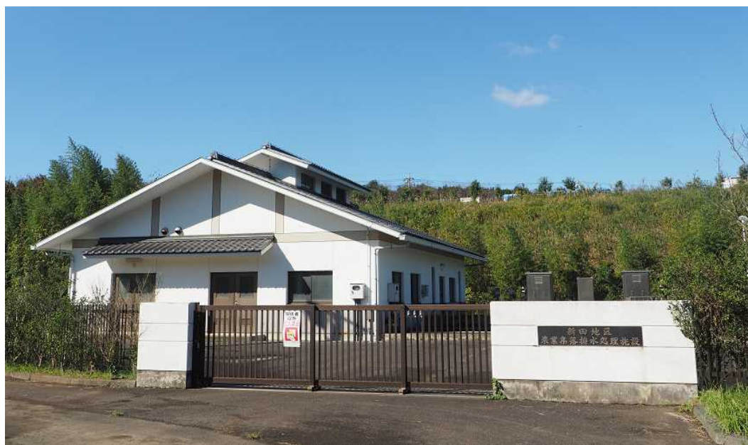
【図 21】農業集落排水処理施設（新田地区）
