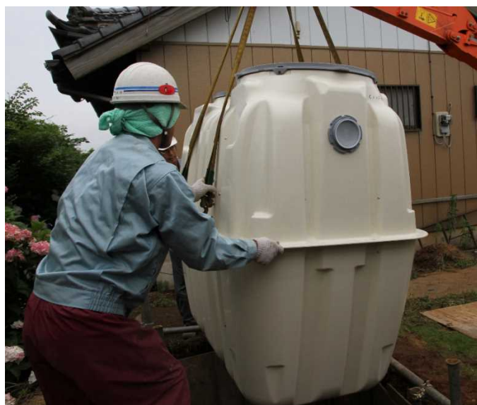
【図 22】小型の合併処理浄化槽（設置工事の様子）
