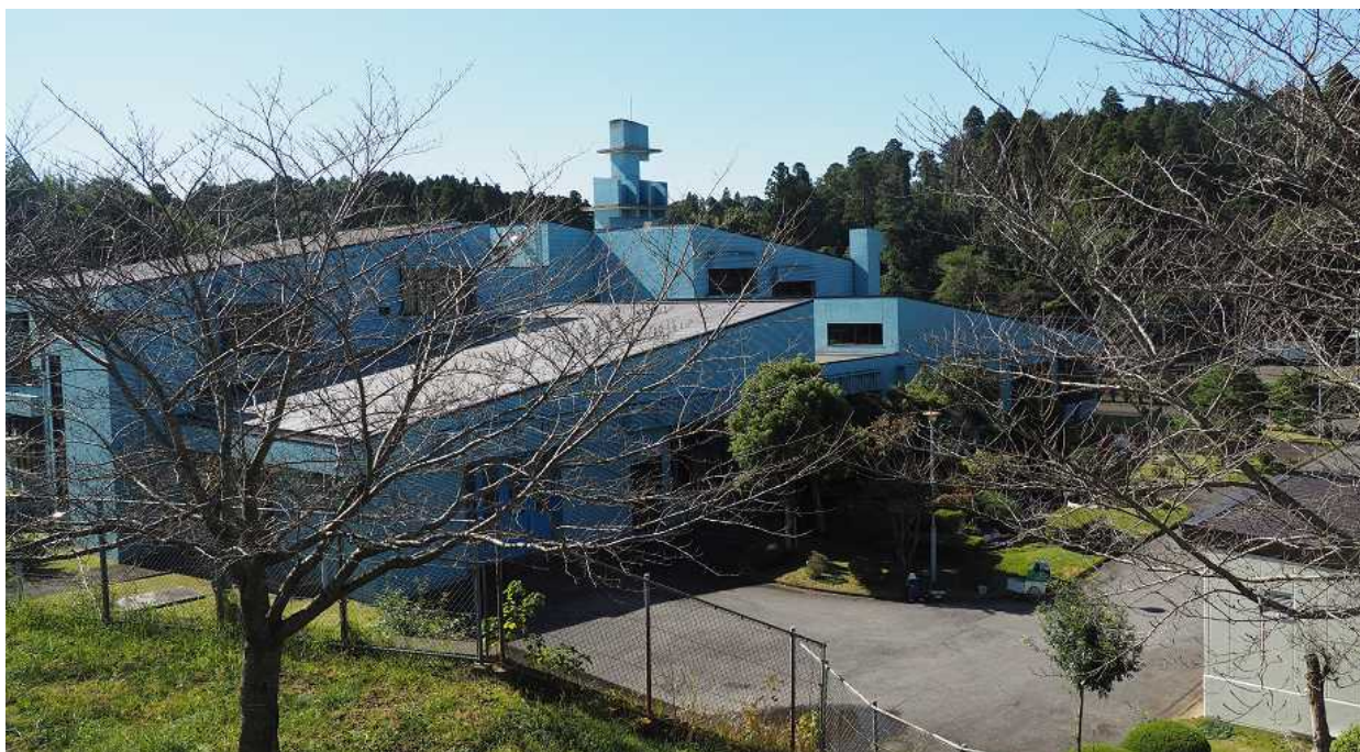
【図 24】成田浄化センター
