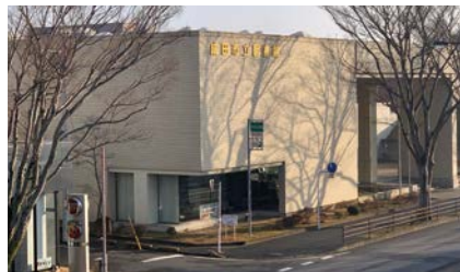
建築後37年が経過した図書館本館
