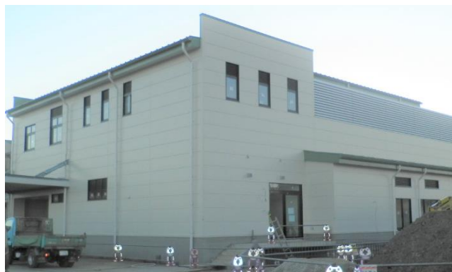
建設工事が進む平成小学校学校給食共同調理場
