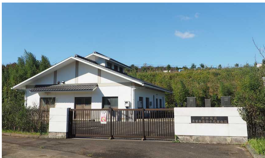
【図 18】農業集落排水処理施設（新田地区）
