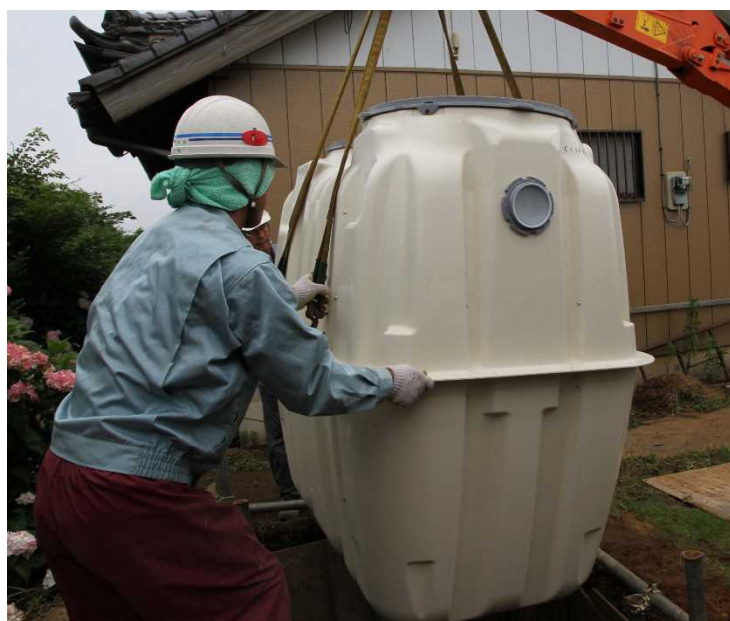
【図 19】 小型の合併処理浄化槽（設置工事の様子）
