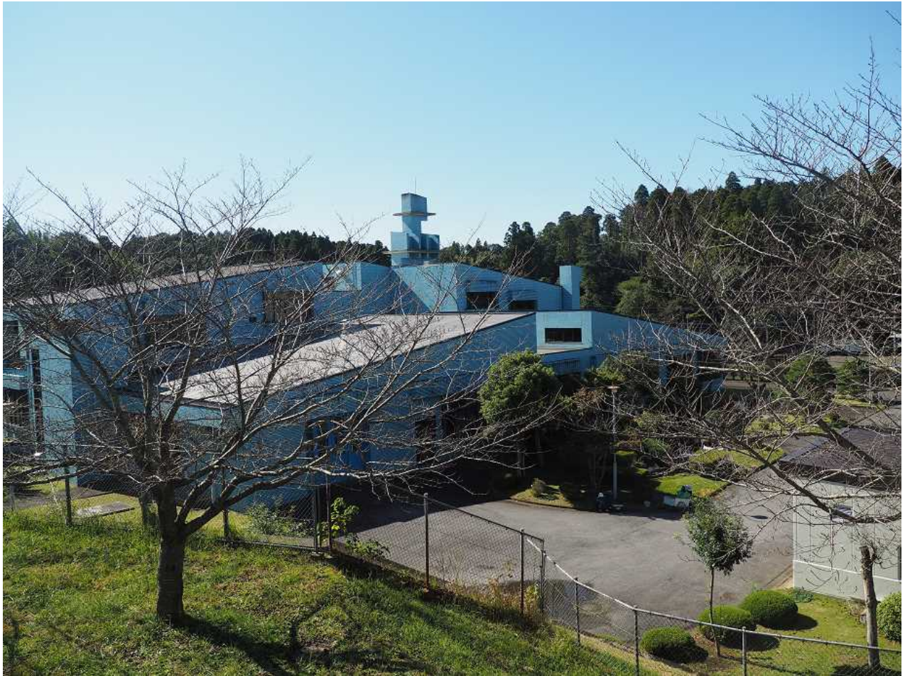
【図 21】 成田浄化センター
