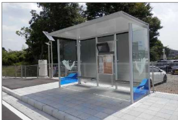
【バス停の上屋整備】（茨城県日立市）
