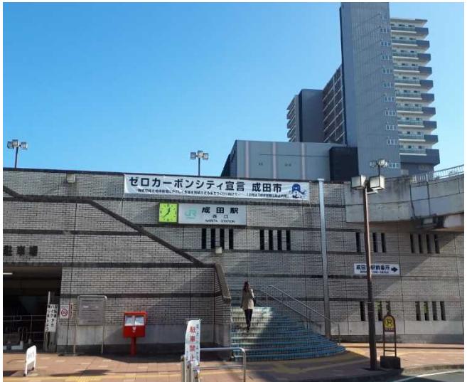
JR 成田駅西口へ横断幕を設置
