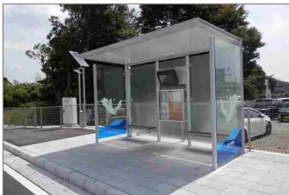
【バス停の上屋整備】（茨城県日立市）
