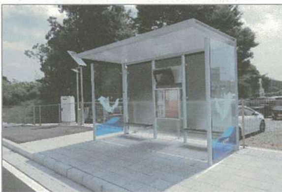
【バス停の上屋整備】（茨城県日立市）
