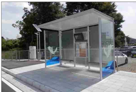
【バス停の上屋整備】（茨城県日立市）
