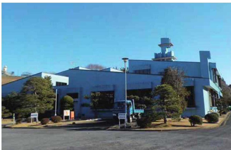
写真：成田浄化センター
