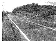
国道51号線の道路改良工事
