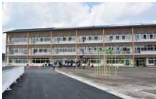
遊具が設置された校庭と校舎
