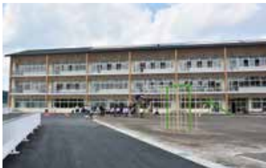
遊具が設置された校庭と校舎
