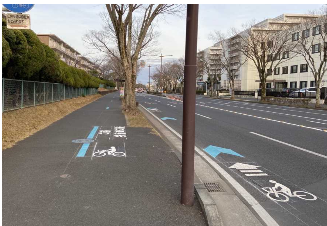
整備された自転車通行帯（令和3年3月 西口大通り）
