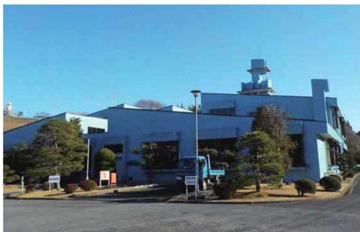
写真：成田浄化センター
