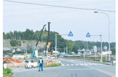
工事中の山之作地先
