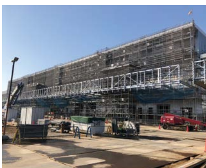
建設工事中の新市場
